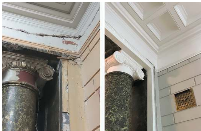
Реставрация колонн на 1-м этаже здания Фотография инженерно-строительной компании ФЛИТ
