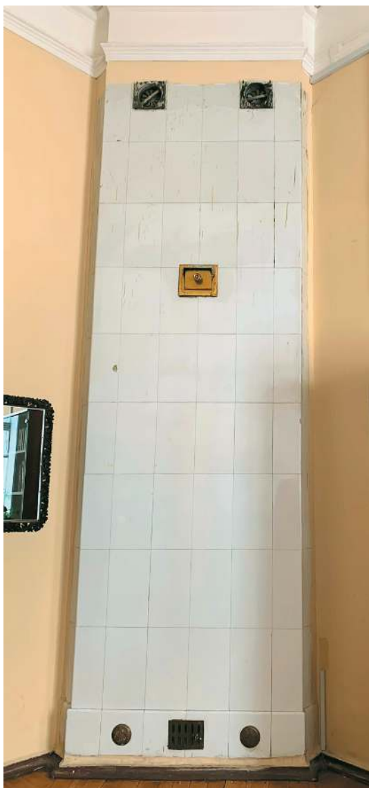
В одном из помещений 2-го этажа
