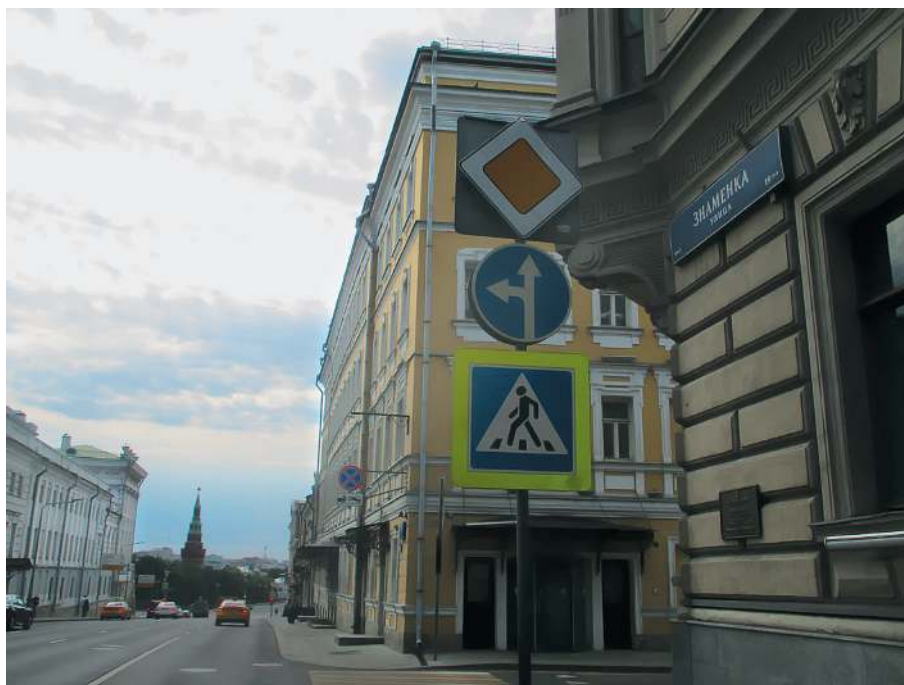
Вид на здание со стороны ул. Знаменка в сторону Боровицкой башни Московского Кремля и Большого Каменного моста
