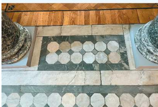
Реставрация напольной плитки на 1-м этаже здания Фотография инженерно-строительной компании ФЛИТ
