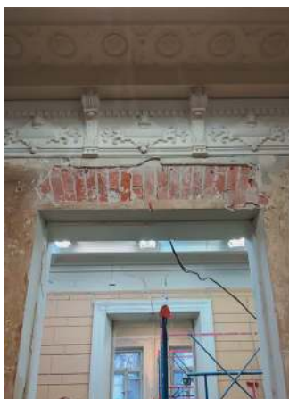
Реставрация лепнины в помещениях здания Фотография инженерно-строительной компании ФЛИТ
